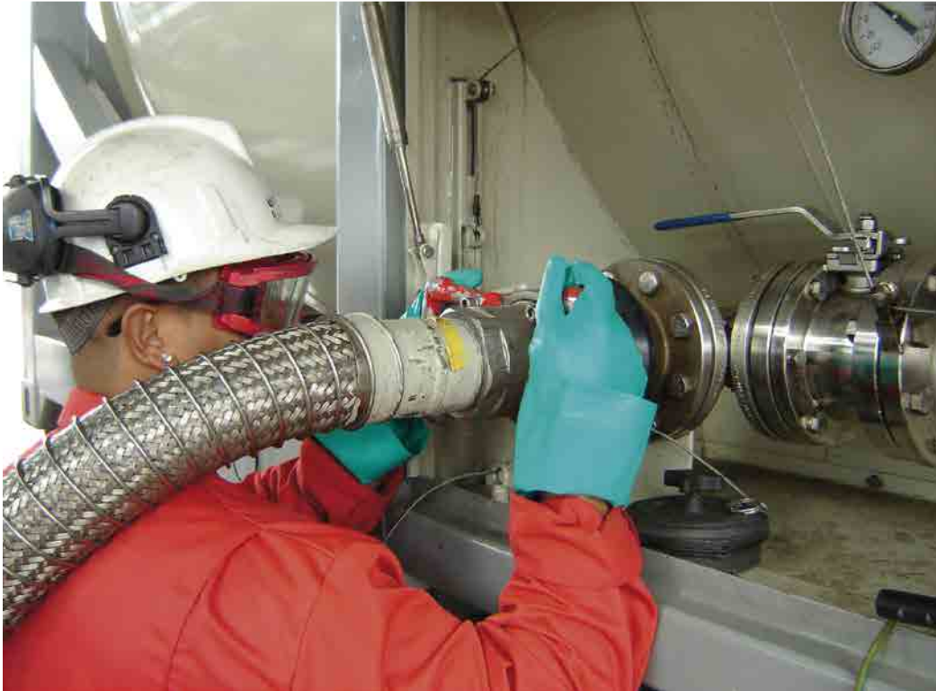
Fig. 4/5 Arbeiter in Schutzausrüstung beim Anschlagen der Flüssigkeitsphase
